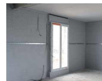
Après la projection de l'Aéroblue® et avant la pose du doublage.
