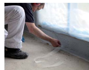
Mise en place de la bande de fibre de verre aux jonctions menuiserie/maçonnerie
